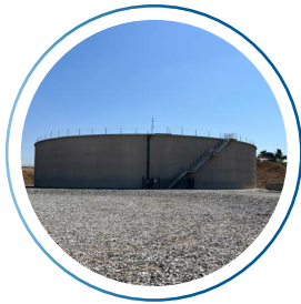
1 Tanque de Hormigón
